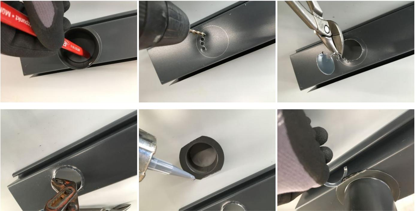
Zeichnen Sie den Ablaufstutzen an der entsprechenden Position an, danach muss das Loch aus der Dachrinne ausgeschnitten werden, sofern vorhanden kann hier auch ein Blechschälbohrer verwendet werden. Nach dem Ausschneiden wird mit einer Zange noch eine Tropfkante an gebördelt, dann kann der Stutzen aufgeklebt werden. Ausgetretener Kleber sollte entfernt werden. Bis der Kleber eine entsprechende Festigkeit hat, darf der Stutzen 2-3 Stunden nicht belastet werden.
