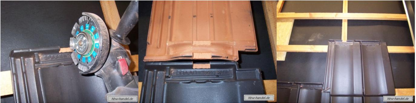
Jetzt kann die Stütze auf dem Sparren angeschraubt werden. Die Stütze sollte nur so weit rausschauen, dass der darüber liegende Dachstein nicht anstößt. Bedingt durch das Rastermaß vom Dachstein, kann die nächste Stütze nicht auf dem Sparren befestigt werden, es muss ein Befestigungsbrett eingesetzt werden. Dieses sollte nicht dicker als die Konterlatte sein und an mindestens 2 Dachlatten verschraubt werden.
