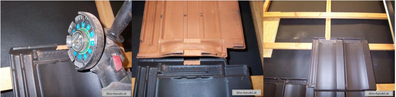
Jetzt kann die Stütze auf dem Sparren angeschraubt werden. Die Halter sollten nur so weit rausschauen, dass der darüber liegende Dachstein nicht anstößt. Bedingt durch das Rastermaß vom Dachstein kann die nächste Stütze nicht auf dem Sparren befestigt werden, es muss ein Befestigungsbrett eingesetzt werden. Dieses sollte nicht dicker als die Konterlatte sein und an mindestens 2 Dachlatten verschraubt werden.
