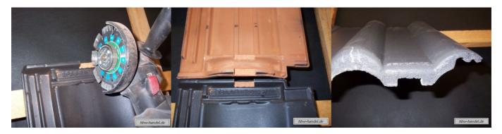
Grundsätzlich ist bei Verwendung dieser Stütze zu beachten, dass zusätzliche Befestigungslatten eingebaut werden müssen, in welche die Stütze eingehängt und befestigt wird. Die Position der Befestigungslatte wird von der Stütze vorgegeben, diese sollte geradlinig auf dem Dachstein aufliegen. Jetzt kann der Halter eingehängt und angeschraubt werden. Die Halter sollten nur so weit rausschauen, dass der darüber liegende Dachstein nicht anstößt.
