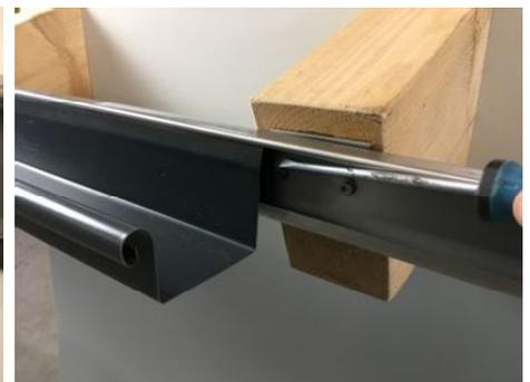
Als Nächstes kann der Ablaufstutzen eingeklebt werden, dieser sollte dann 2-3 Stunden nicht belastet oder bewegt werden, bis der Kleber eine entsprechende Festigkeit hat. Danach kann die Dachrinne seitlich in die Schiene eingeschoben werden, ggf. muss die Rinne bei den Befestigungsschrauben mit einem Schraubendreher etwas vorgedrückt werden.
