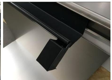
An den Stoßstellen sollte vor der endgültigen Positionierung der Verbinder seitlich in die Rinne eingeschoben werden. Für den Einbau der Verbinder, Endstücke und Ablaufstutzen beachten Sie bitte die zusätzliche **Einbauanleitung für Dachrinnenzubehör**.
