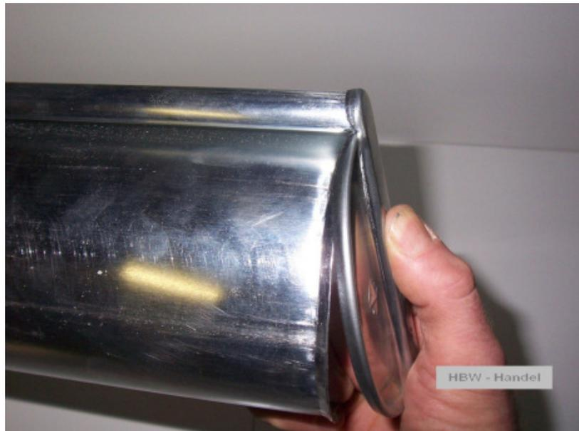
**Schritt 3:** drücken Sie die Falzung des Bodens mit einer Zange zusammen, zur Lagesicherung empfiehlt es sich den Boden mit einer Hand etwas festzuhalten
