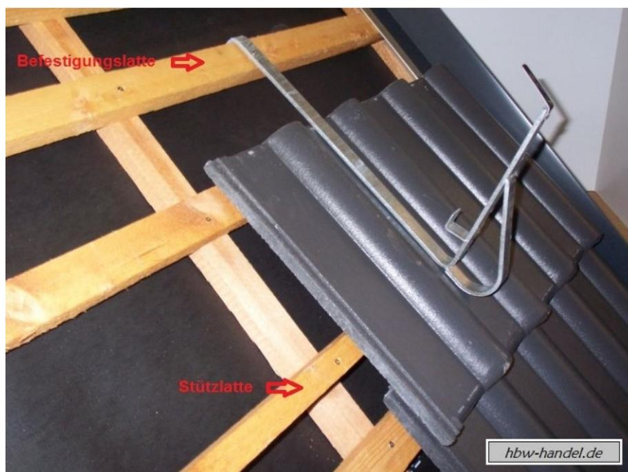
Der überdeckende Dachstein sollte im Bereich der Stütze mit dem Winkelschleifer ausgeklinkt werden.
